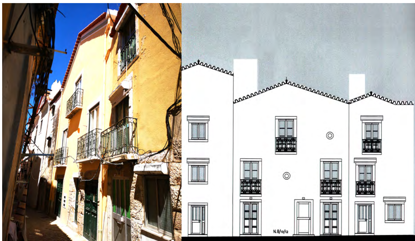
Fig. 2 - Fachada, meridional, do edifício 8-12 da Rua Vasco Soveral.
